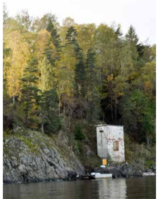
På østsida av Mulodden ligger den gamle trafostasjonen ved sjøkabelen til Langøya.
